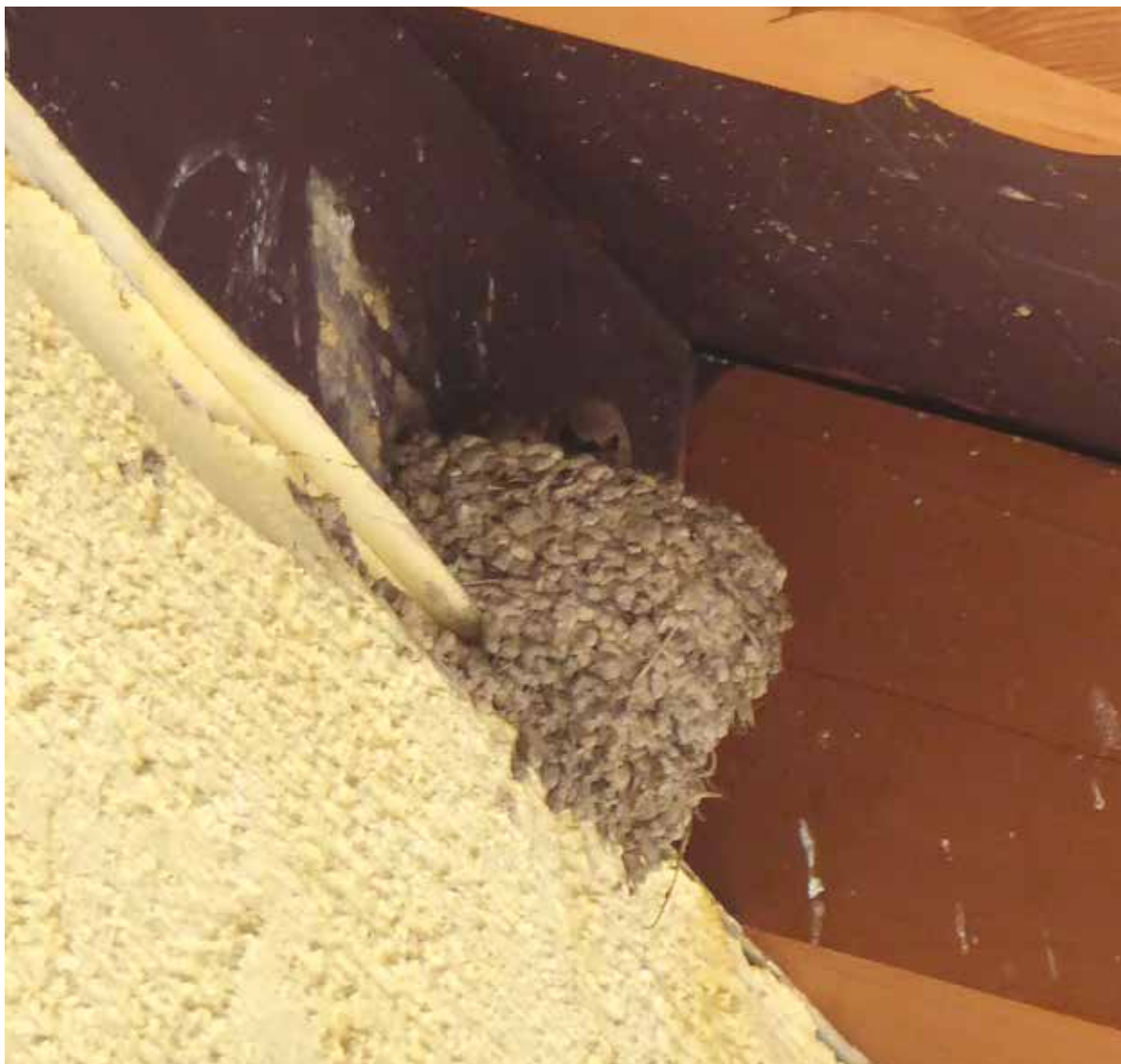
Nido con rondine montana sotto il tetto di Castel Trauttmansdorff.
